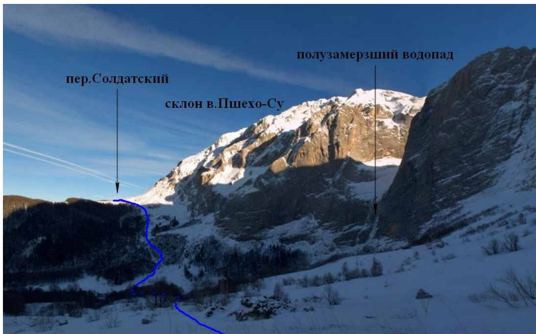
Фото Б.24 – Вид с левого борта д. р. Водопадистый
